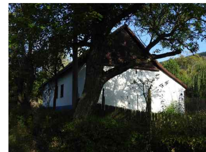
obr. č. C. 266: Sousední hodnotná okapově orientovaná usedlost s modrou podrovnávkou zapojená ve vzrostlé zeleni
