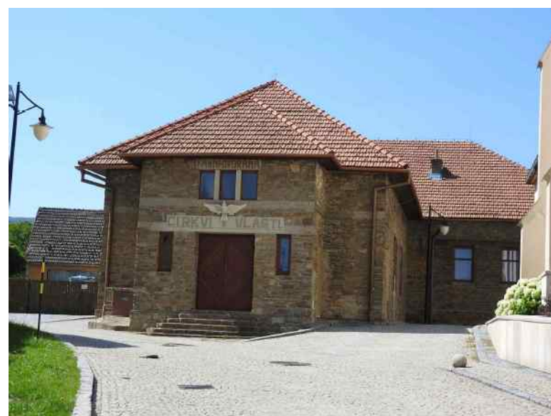
obr. č. C. 553: Přestavěný polyfunkční objekt získal vhodnější výraz kultivovaným řešením fasády, oken včetně jejich barevného zvýraznění a také novým zastřešením, které je v daných podmínkách přijatelnější než původní plochá střecha
