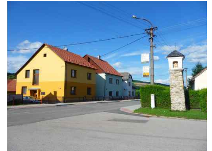
obr. č. C. 631: Reprezentativní stavba obecního úřadu má soudobý výraz a působí přirozeně dominantně v kontextu okolní zástavby
