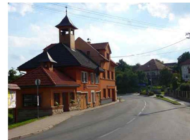
obr. č. C. 533: Svěbytná zajímavá architektura, pro danou komerční funkci je takové zvýraznění uprostřed obce akceptovatelné; příznivě se v místním prostředí uplatňuje užití dřeva
