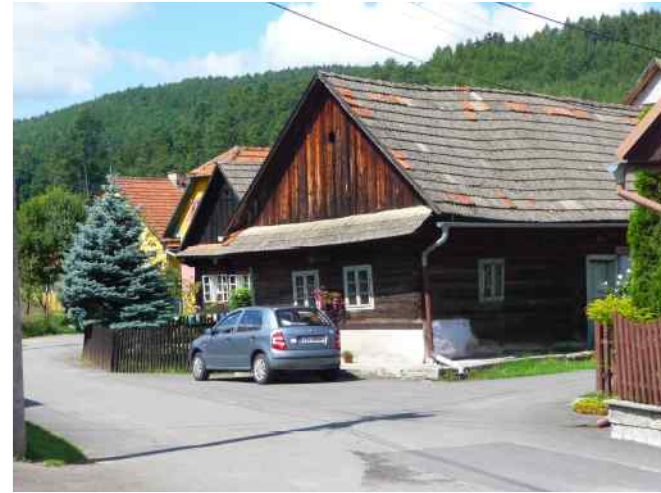
obr. č. C. 304: Dvě jednoduché dřevěnice jsou dokladem původních valašských staveb; rušivě působí zadní vyšší část s nevhodnou přístavbou, schodištěm a obkladem podezdívky
