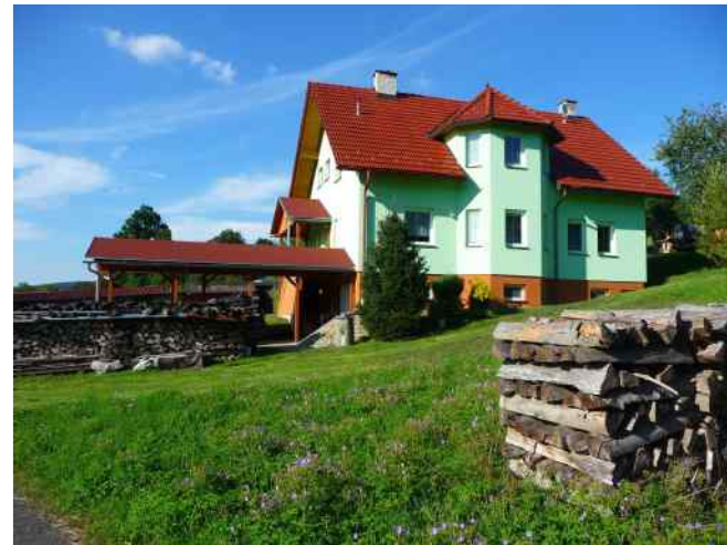
obr. č. C. 160: Architektonicky vyvážená stavba působí jako solitér celkem příznivě; vhodně by se uplatnila v jiném, méně exponovaném území; v horském prostředí CHKO Bílé Karpaty jde ale o nepůvodní typ stavby, která není v souladu s civilizačními hodnotami území
