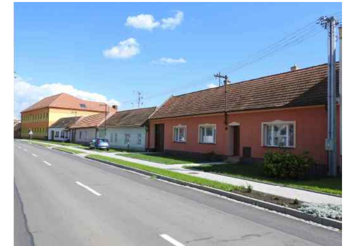
obr. č. C. 190: Novostavba bez předpokladů k začlenění do okolní zástavby v sídle
