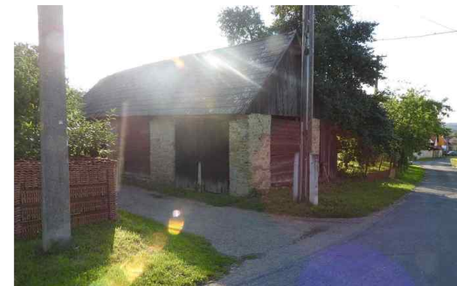
obr. č. C. 101: Objekt stodoly zachovalého měřítka v blízkosti kaple kombinující kámen a dřevo jako stavební materiál
