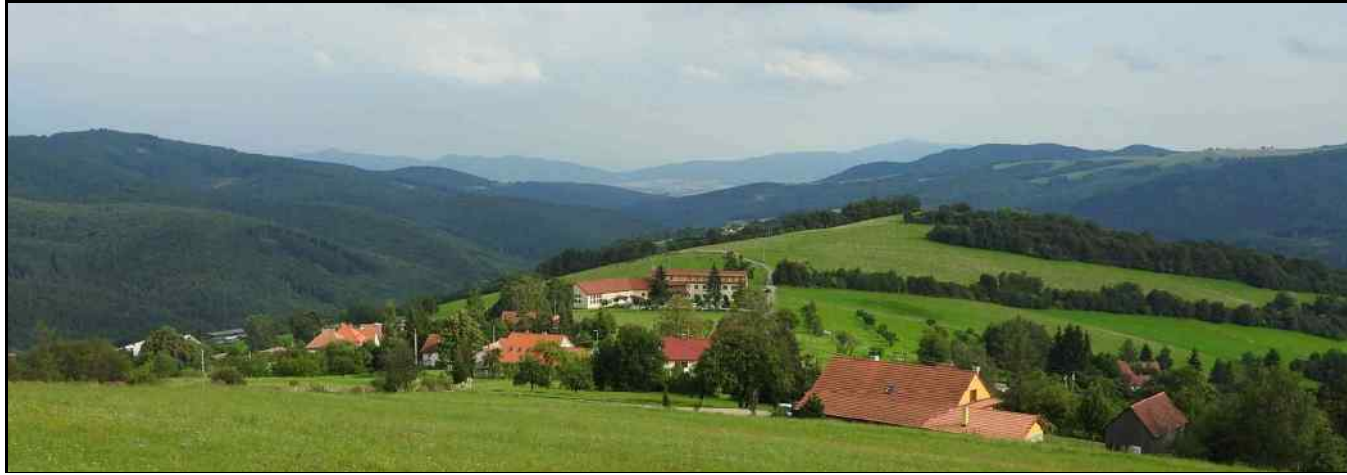
obr. č. C. 732: Obnovou si velká stavba původní školy zachovala všechny původní atributy; výraz stavby ve vysoce hodnotném krajinném kontextu zůstal hmotově beze změn
