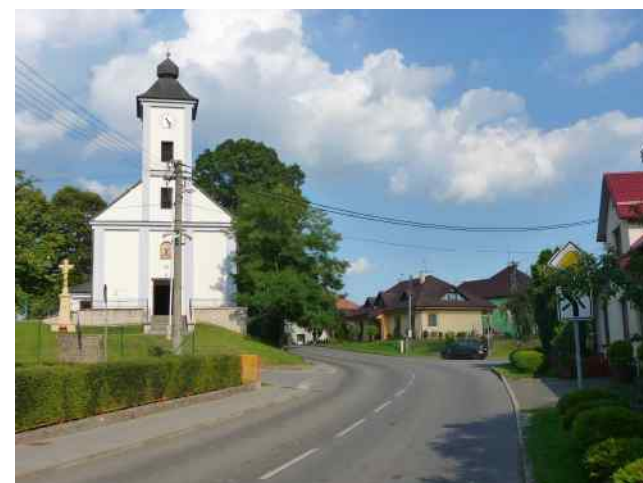
obr. č. C. 532: Rodinný dům z 1. pol. 20. století trochu ztratil ze svého autentického výrazu výměnou oken; původní okna se zřejmě vyznačovala zdobností a obdobným členěním (ponechané) výtvarně zajímavé zasklení verandy
