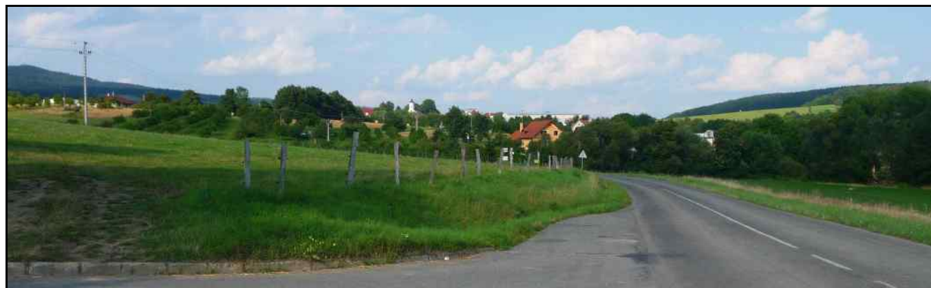
obr. č. C. 527: Slopné v pohledu z jihozápadu, vystupuje kostel a výrobní areál jižně od něj
