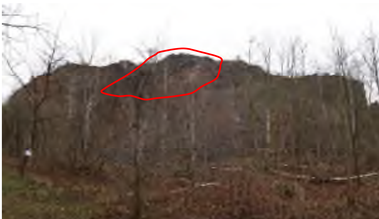
Obrázek 13: pohled na strmou skalní stěnu s vyznačením pozice nestabilní masy horniny ve vysoké lokaci
