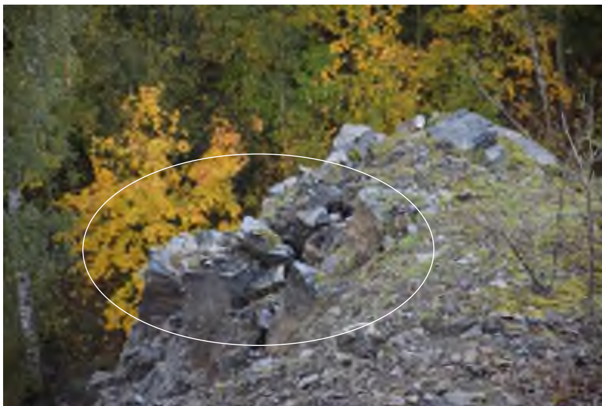
Foto 6 Ukázka dílčích nestabilních částí skalní stěny opuštěného lomu – zvýrazněno bílou elipsou . Mocnost trhlinou oddělené části lze odhadovat (fotografováno teleobjektivem) na přibližně 1 m.
