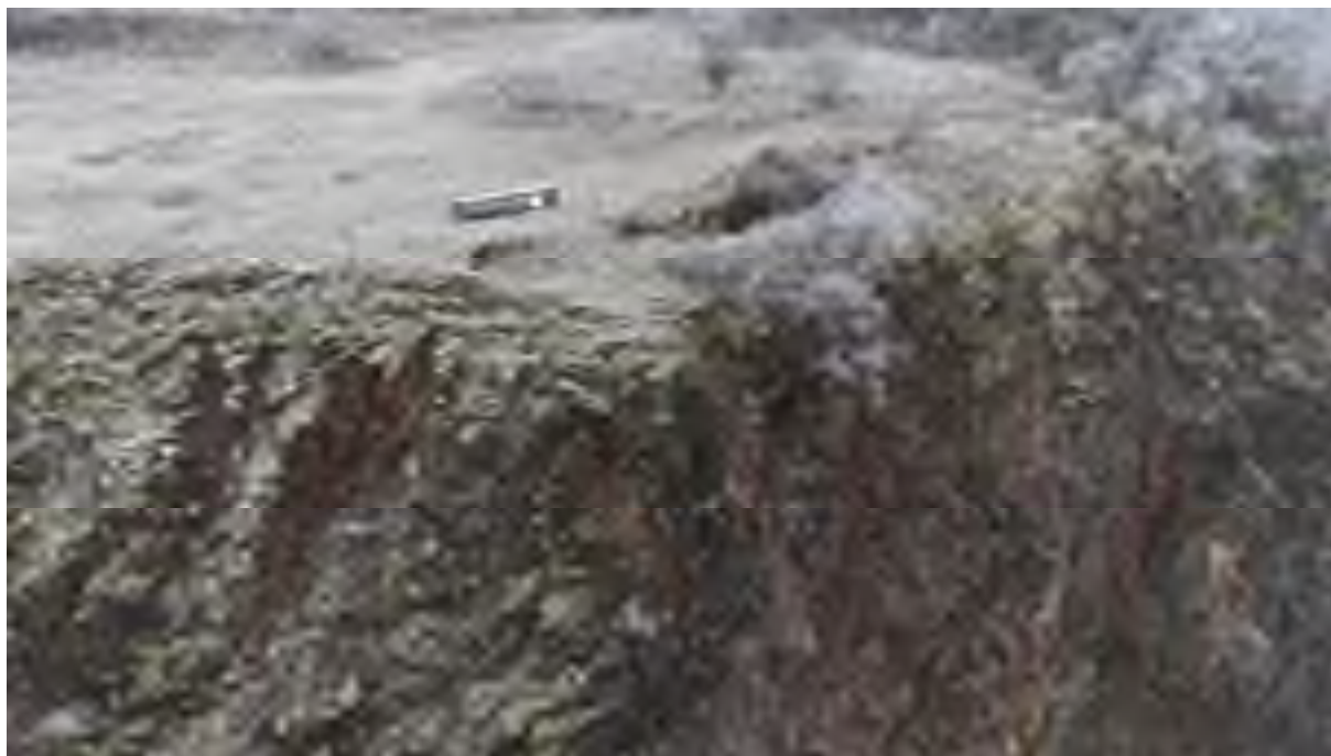
Obrázek 16: pohled na horní partie a významné projevy svahové nestability masivu, poklesy a oddělení masivu na horní hraně dosahují řády až jednotek metrů
