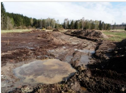
Zakládání hráze velké tůně (na způsob malých rybníčků, které jsou v regionu časté). (V. Kodet)
